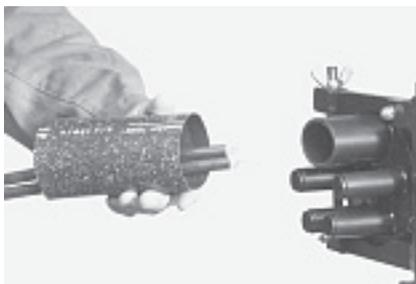
**4.3** Удалите чистой тканью землю, грязь и другие вещества с оболочки кабеля на длине около 2 метров. Возьмите овальную герметизирующую трубку и наденьте ее на кабеля. Неокрашенный край трубки и стрелки на трубке должны быть направлены к основанию муфты.
