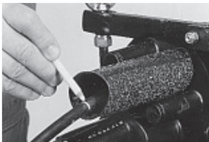
**11.8** Надвиньте термоусаживаемую трубку на кабельный ввод основания муфты FOSC до упора в основание. Отметьте длину трубки на оболочке кабеля.
