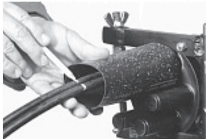
**6.3** Наденьте овальную герметизирующую трубку на овальный ввод и кабель. Пометьте длину трубки на кабеле.
