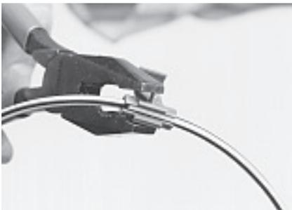
**5.6** При необходимости сохранить непрерывность экрана кабелей соедините зажимы экрана соответствующими проводами. Телефонные пары, если таковые имеются, должны быть соединены в соответствии с принятыми правилами.
