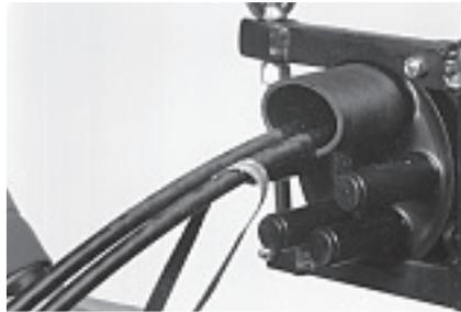
**6.2** Очищенные овальный ввод и оболочку кабеля обработайте по окружности наждачной полоской. Чистой тканью удалите все остатки обработки.
