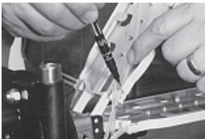
**8.2** Выполните сращивание волокон, как описано в пункте 7. Однако оставьте достаточный запас переходных трубок чтобы при повороте лотка на шарнире трубки сильно не изгибались и не перекручивались.
