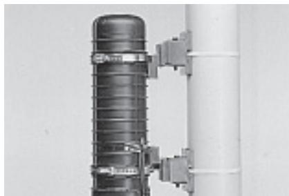
**14.1** Установите два крепежных кронштейна из комплекта FOSC-A/B-POLE-MOUNT на корпусе муфты. Вставьте кронштейны в ответные кронштейны на опоре и закрепите их блокирующим штифтом.
