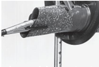
**6.6** С помощью фена и рефлектора усадите овальную герметизирующую трубку со стороны основания муфты. Усаживайте трубку до тех пор, пока зеленая термоиндикаторная краска не изменит свой цвет на черный. (Удостоверьтесь, что температура горячего воздуха не ниже 350°C).
