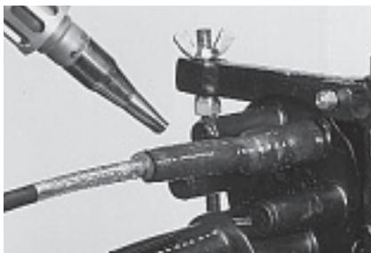
**11.11** Продолжайте усаживать трубку в сторону кабеля. Нагревайте до тех пор, пока трубка не усадится на кабели и зеленая термоиндикаторная краска не станет черной. Кольцо красного клея должно быть видимым на кабеле и на крае трубки.
