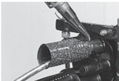
**11.10** Надвиньте герметизирующую трубку на ввод. С помощью фена усадите герметизирующую трубку со стороны основания муфты. Используйте рефлектор для равномерного распределения тепла вокруг ввода. Усаживайте трубку до тех пор, пока зеленая термоиндикаторная краска не изменит свой цвет на черный.
