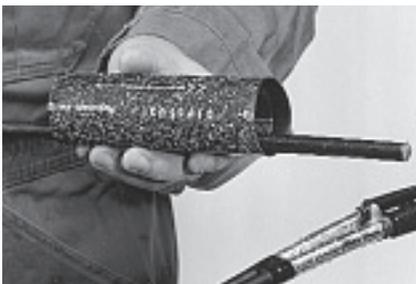
**11.2** Удалите чистой тканью землю, грязь и другие вещества с оболочки кабеля на длине около 2 метров. Возьмите герметизирующую трубку из комплекта FOOSC-A-CSEAL-1-NT и наденьте ее на кабель. Неокрашенный край трубки и стрелки на трубке должны быть направлены к основанию муфты.
