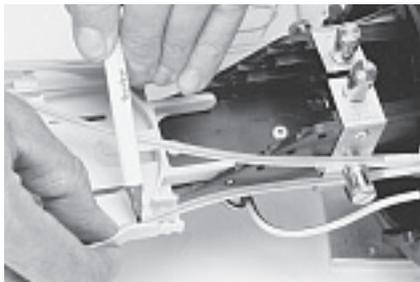
7.1.1 Каждый лоток рассчитан на максимум 8 сростков волокон и с каждой стороны лотка можно разместить максимум 4 больших переходных трубки. Разместите трубки на дне лотка и выровняйте их по длине. Пометьте каждую трубку на лотке на расстоянии 15 мм от края лотка.
