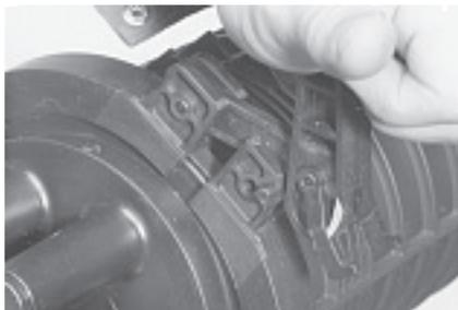
**9.4** Осторожно наденьте корпус муфты поверх лотков на основание. Наденьте хомут на место стыка основания и корпуса муфты. Закройте хомут.
