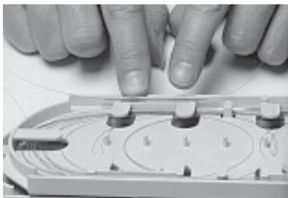
7.1.5 Каждый смонтированный сросток должен быть помещен в держатель сростков. Вставляя сросток в держатель не деформируйте защитную трубку. Запас волокна должен быть уложен витками на лотке.
