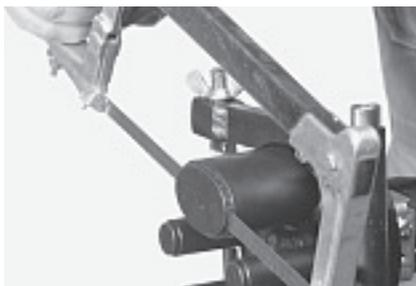
**4.2** Установите муфту FOSC в держатель FOSC-STAND и откройте овальный кабельный ввод срезав с помощью ножовки наконечник ввода. Обработайте внутренний край открытого ввода наждачной полоской.
