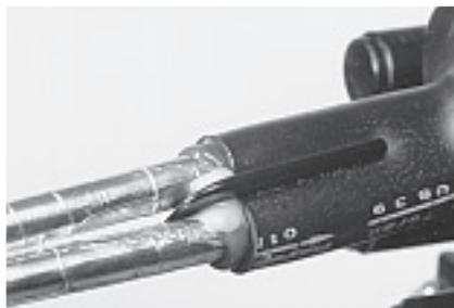
**6.7** Продолжайте усаживать трубку в сторону кабелей. Нагревайте до тех пор, пока трубка не усадится на кабели и зеленая термоиндикаторная краска не станет черной. Затем нагрейте зажим с обеих сторон до тех пор, пока клей не выступит из зажима в промежутке между двумя кабелями.
