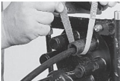
**11.7** Очищенные ввод и оболочку кабеля обработайте по окружности наждачной полоской. Чистой тканью удалите все остатки обработки.
